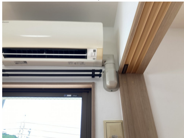
16.エアコンクリーニング
